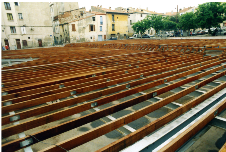
Lambourdage sous le platelage de la place du Forum Saint-Martin - Perpignan (France)
